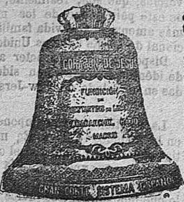
Alcación pura de cobre y estaño. Retundición de las rotas. Trazo matemático en toda forma de campana.
