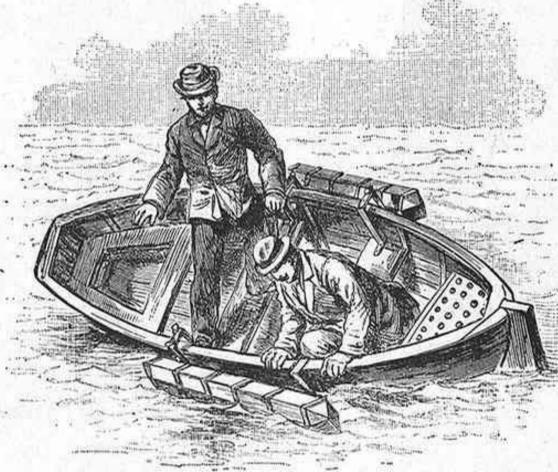
Fig. 2. - Aparato de seguridad del Sr. Dehnicke. Los tripulantes del bote haciendo inútilmente esfuerzos para que éste zozobre.
