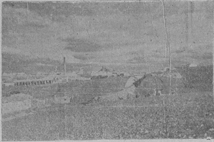
En el trayecto Chamberi-Tejares, se abren trincheras y se levantan terraplenes, que buscan el nivel del nuevo ramal ferroviario. Precisamente, en este mismo tramo, se asentará, con fácil acceso a la carretera y a Tejares y Chamberi, la nueva estación
