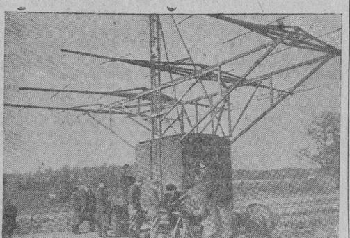
Un aspecto de la instalación del Radar montada por el profesor británico Sir Edward Appleton, para realizar experimentos relativos a la acción antiáerea de este nuevo invento
