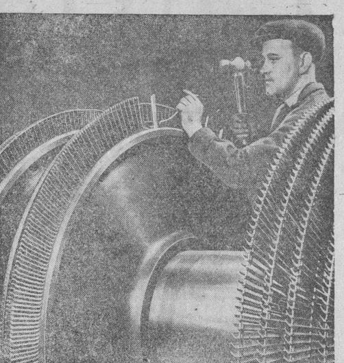
La Gran Bretaña ha puesto en servicio todas las grandes fábricas productoras de material de guerra para la construcción de barcos, construyendo actualmente más de la mitad del tonelaje mundial. He aquí una instalación de las cuchillas de acero en la rota giratoria de un motor de turbina de vapor. La corriente de alta presión que pasa entre las cuchillas, hace girar la turbina a más velocidad. (Foto Calpe)
