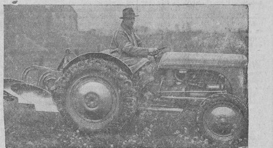
En la actualidad se está fabricando en Inglaterra un nuevo tipo de tractor, destinado a múltiples aplicaciones agrícolas, capaz de rendir un perfecto trabajo bajo las peores condiciones climatológicas. Se trata del tractor Ferguson, que vemos en esta fotografía, el cual, gracias a un dispositivo especial, permite el levantamiento del mismo, adaptándose a cualquier terreno
