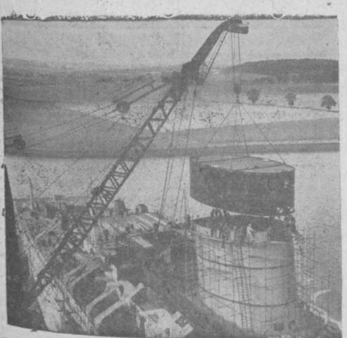
Para la Cunard Star Line está construyéndose el buque "Caronia", de 34.000 toneladas. La foto recoge el momento de colocación de una de las secciones de la chimenea, con un peso de quince toneladas.
