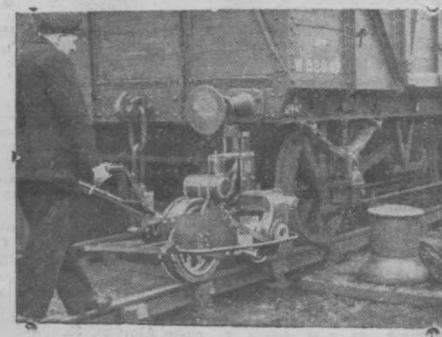
En Gran Bretaña, viene utilizándose un impulsor mecánico para vagones, que permite realizar las maniobras con rapidez y facilidad, ahorrando personal y carbón, a fin de eliminar el servicio de las locomotoras en las maniobras.
