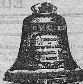
Alceación pura de cobre y estaño. Refundición de las rotas. Trazo matemático en toda forma de campana.
